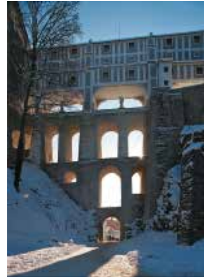
Die Mantelbrücke – ein überdachter dreistöckiger Gang über dem Burggraben.
