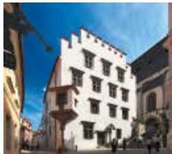
Kaplanka – das erste Bauwerk von Český Krumlov mit Renaissance-Elementen.
